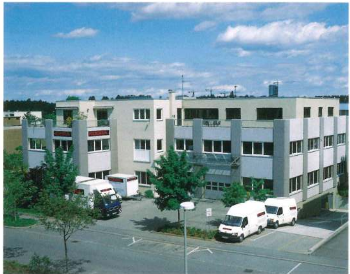
Stammwerk mit Verwaltung in Stuttgart
