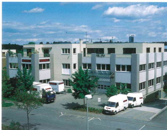
Stammwerk mit Verwaltung in Stuttgart
