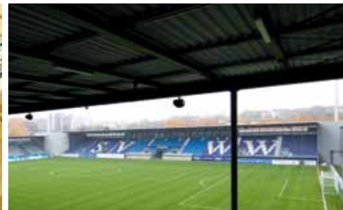
Brita Arena, Wiesbaden (Deutschland)
