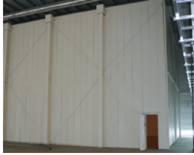
Wertschutzraum fertig montiert in Front- und Seitenansicht, in der Front die Tresortür
