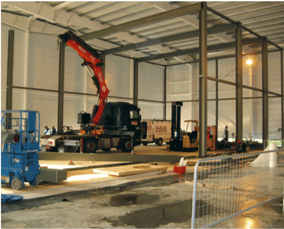
Das Stahlskelett im Aufbau
