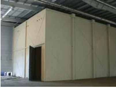
Wertschutzraum fertig montiert in Front- und Seitenansicht, in der Front die Tresortür
