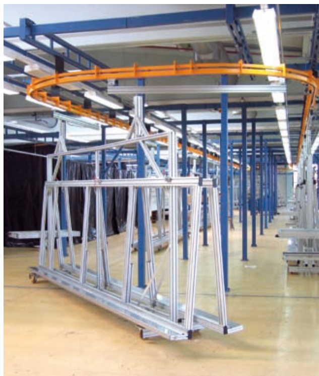
Power & Free Anlage zur Montage von kundenspezifischen Kabelsätzen
