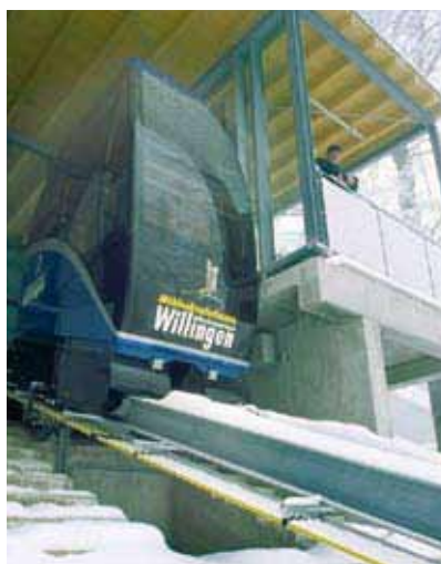
Mit uns ganz nach oben! SinglePowerLine 0812 an einem People-Mover einer Skisprungschanze
