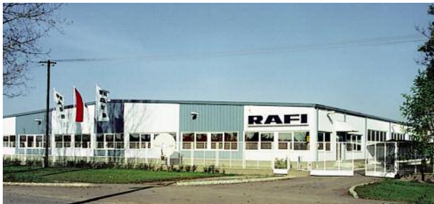
■ Montagewerk in Ungarn (Mezötúr)
