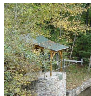
Messstelle mit Radarsensor
