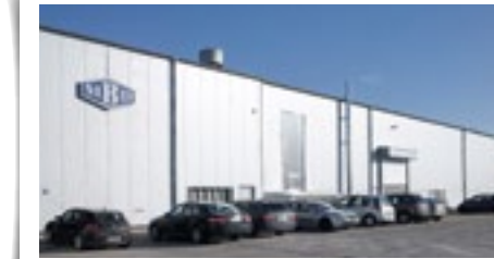
Maschinenbau Buch GmbH Döbeln
